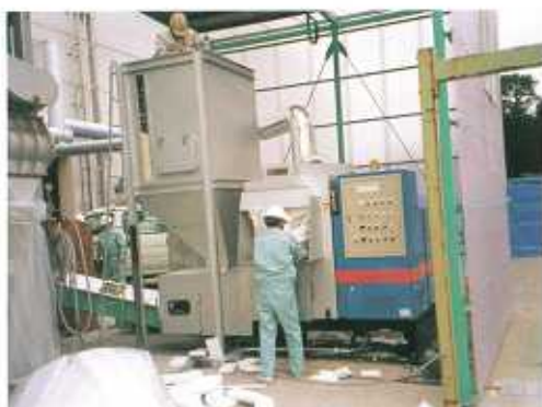
1. 左側ホッパーが木粉ホッパーで、発泡スチロールの溶融吐出口で混入。
